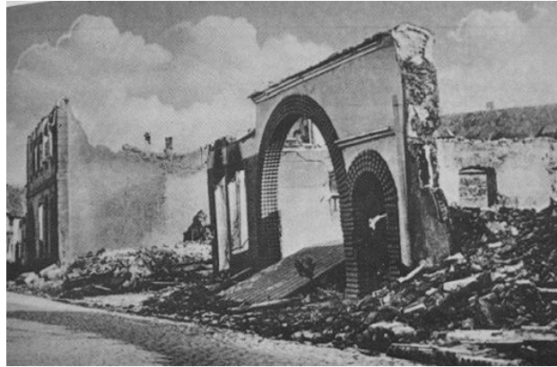
Démolition lors de la Seconde Guerre mondiale (Crédit photo Ville de Lauterbourg, publication : flânerie dans Lauterbourg, 1986)
